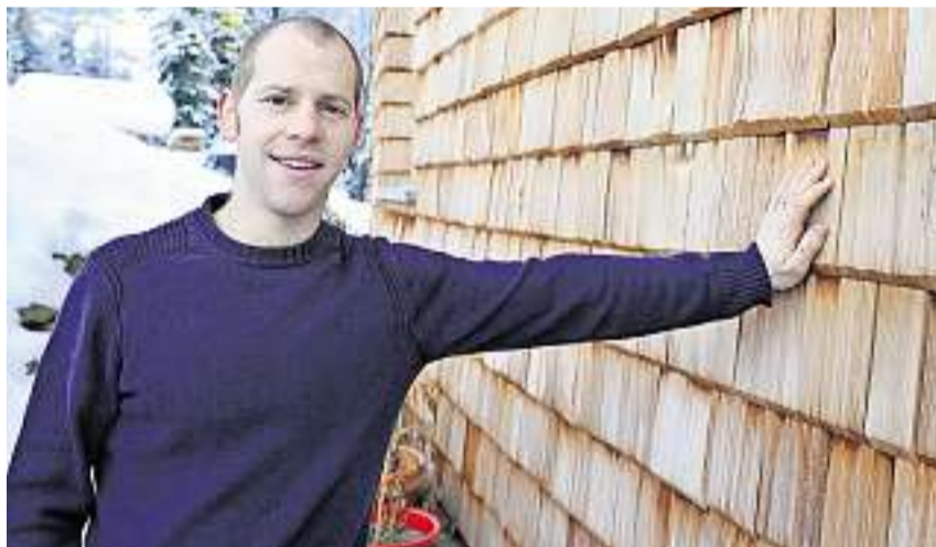
Zedernholzschindeln an der Fassade: Lukas Gwerder hat dieses Material wegen seiner Langlebigkeit und als Insektenabwehrschutz gewählt.
